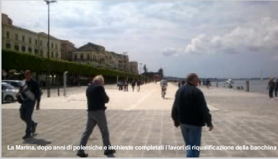
La Marina, dopo anni di polemiche e inchieste completati i lavori di riqualificazione della banchina
