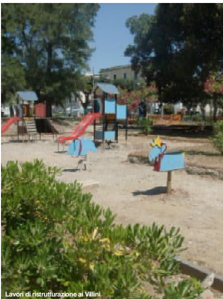
Lavori di ristrutturazione ai Villini
