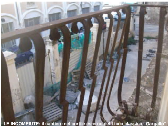
LE INCOMPIUTE: il cantiere nel cortile esterno del Liceo classico "Gargallo"
