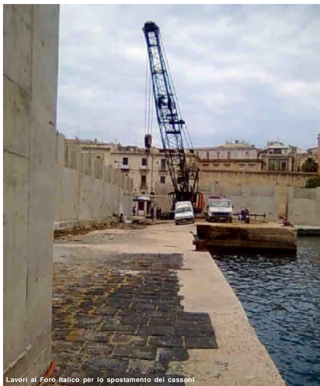
Lavori al Foro Italico per lo spostamento dei cassoni
