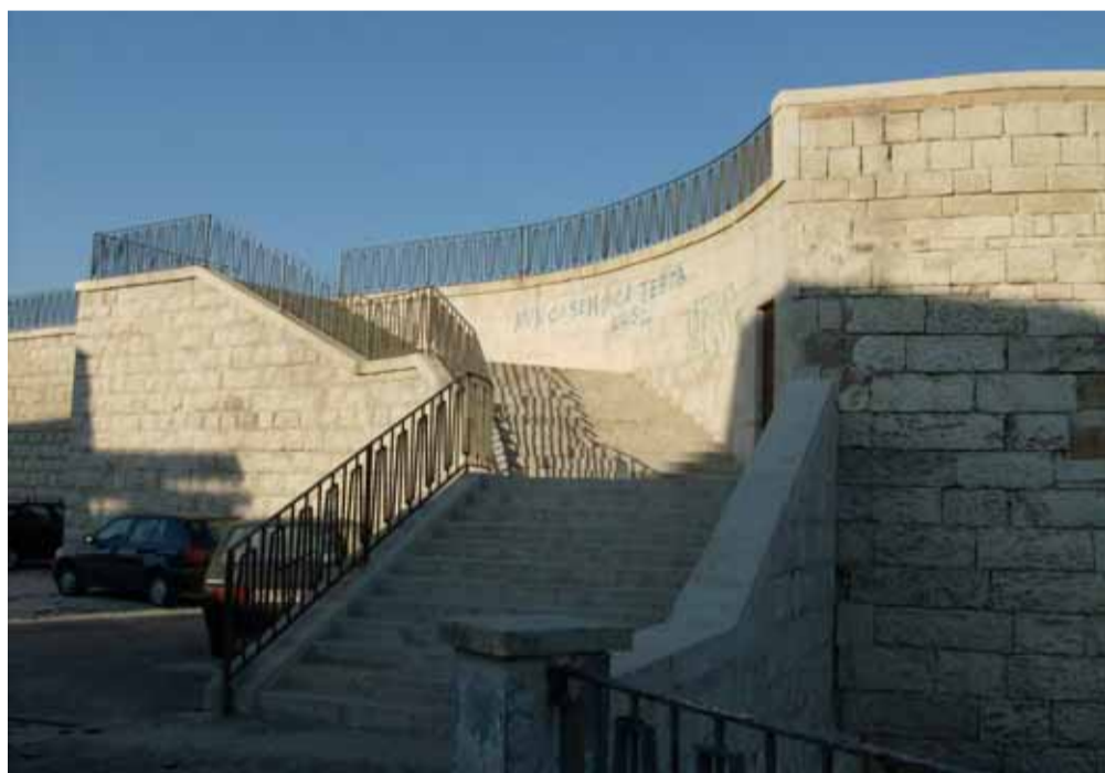
ORTIGIA, BASTIONI DEL QUARTIERE VECCHIO: recupero delle mura cinquecentesche della città.
