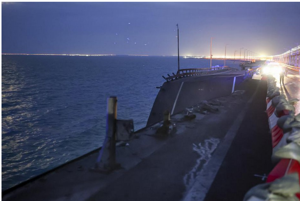
La porzione del ponte crollata (AP Photo)
